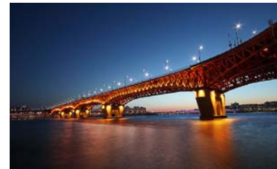
성수대교 (聖水大橋)
